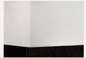
Mineralputz fertig aufgebracht
